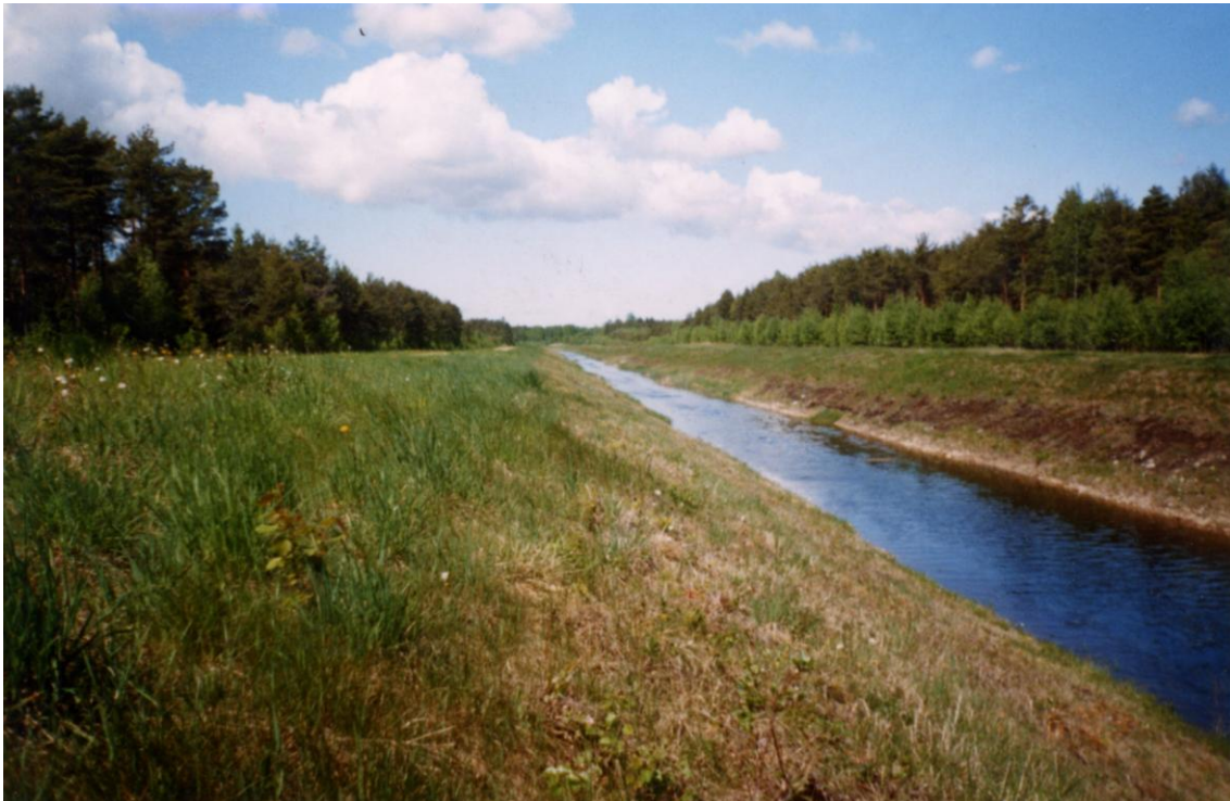
Foto 2. Planeeritav ala kirdepiiril kulgeb Tallinna veevarustuse süsteemi kuuluv Jägala-Pirita kanal.
