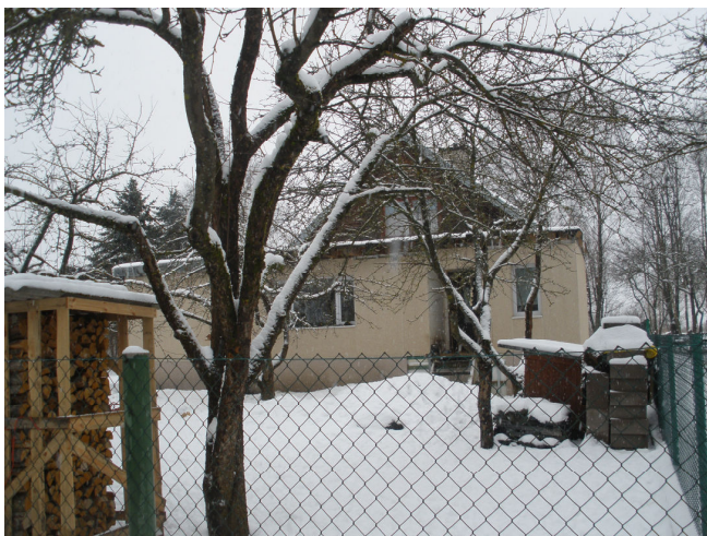
Foto 3 – Kinnistul Radist-31 paiknev kahekorruseline (1+katusekorrus) põhihoone
