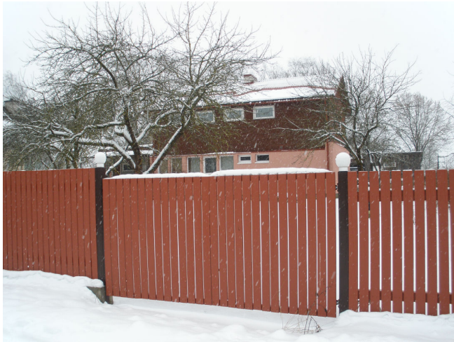
Foto 2 – Kinnistul Radist-33 paiknev kahekorruseline põhihoone
