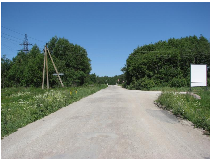
Vaade Betooni tn pikendusele ja olemasolevale raudteeülesõidukohale.
