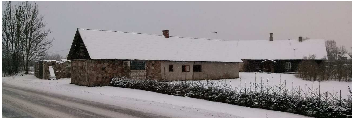
Vaade Tõnikse kinnistul paiknevatele hoonetele
