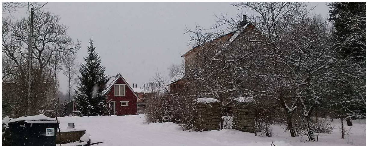
Vaade Kangru kinnistu renoveeritud taluhoonetele
