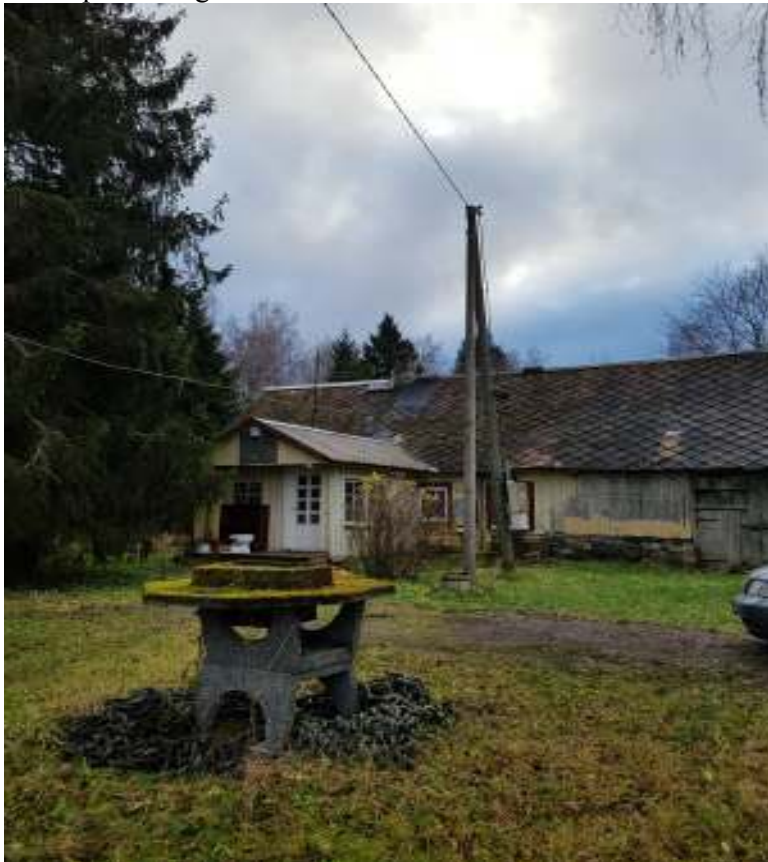
Vaade Ammuta kinnistu olemasolevale eluhoonele põhjast lõuna suunas
