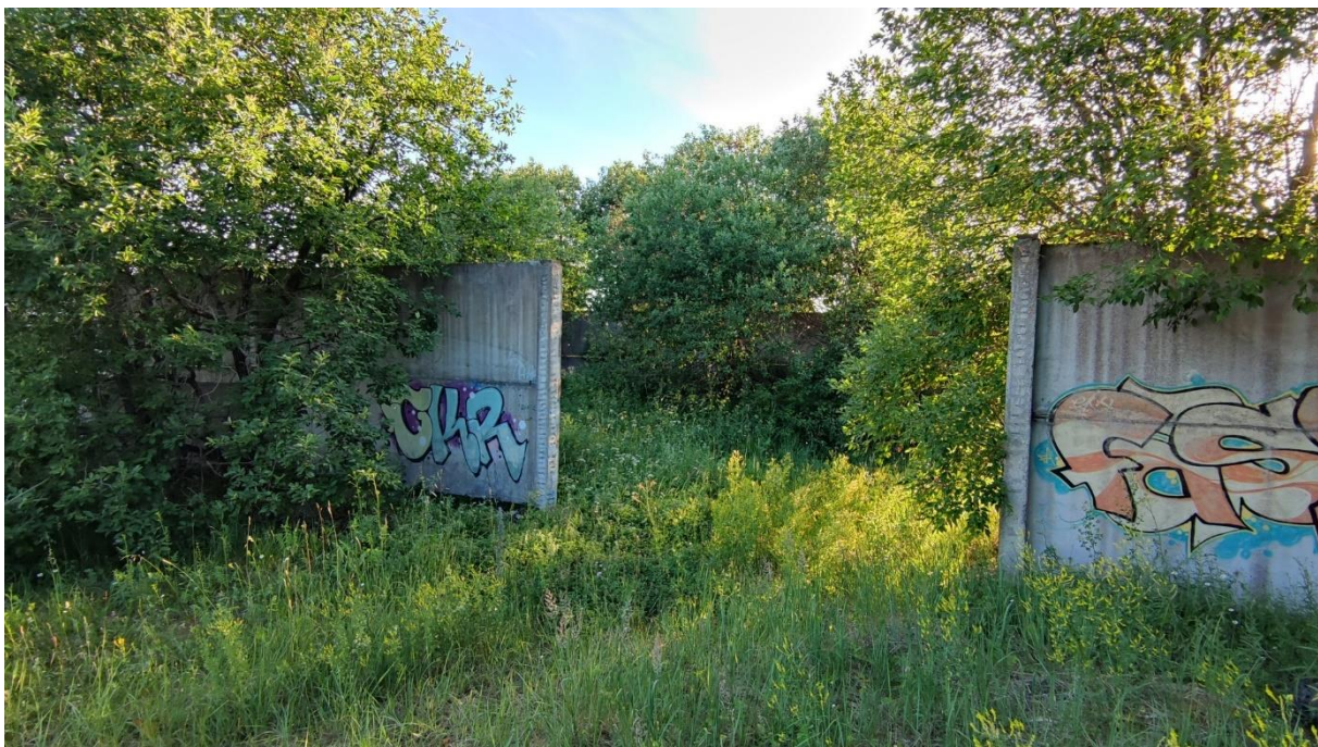
Remmelgate domineerimisega ning betoonseintega liigendatud ala veeremidepoo ala kesk-idaosas. Foto: keskkonnaekspert Raimo Pajula
