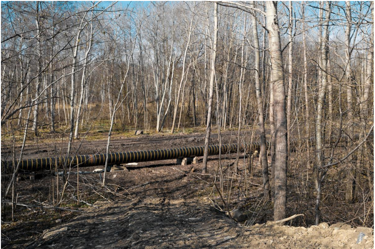
Foto 1. Vaade Rae rohesilla asukohale lõunast. Esiplaanil on näha uue gaasitrassi rajamine ning tagaplaanil olemasolev gaasitrassi avatud koridor, mille kohale tuleb RB süvend. Foto: J. Remm 20.04.2023.
