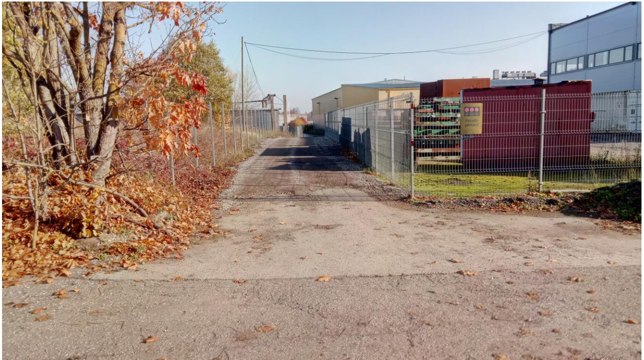
VAADE ARUKÜLA TEE 53 JA ARUKÜLA TEE 57A KINNISTUTE VAHELISELE IDA-LÄÄNE SUUNALISELE TEELE, SUUNAGA LÄÄNDE
