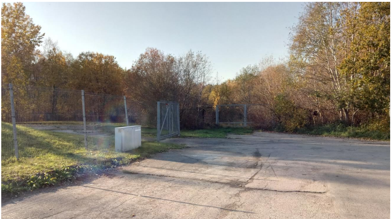
VAADE ARUKÜLA TEE 57E JA 57F SISSEPÄÄSU VÄRAVATELE
