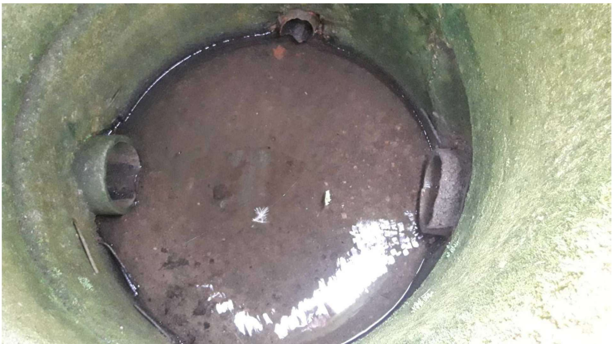
Neelukaevu K2 sisevaade: sissevoolu toru paremal (lõunapoolsest kaevust T1, Tehnovõrkude koondplaani joonise DP-5 geodeetilisel alusplaanil on kaevu nr K1 ), väljavoolutoru vasakul:
